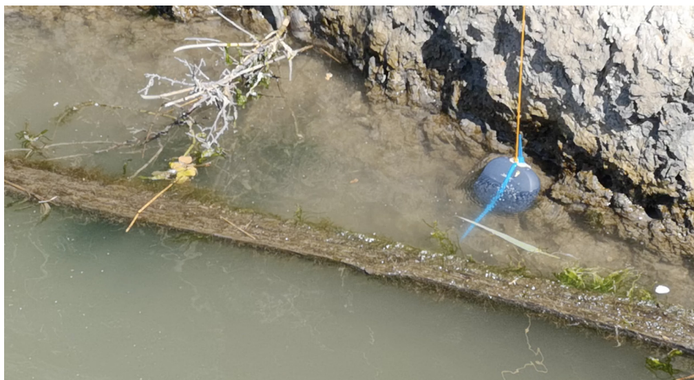
bulles de l'enceinte sous-marine : Canal du Rhône à Sète, Camargue
