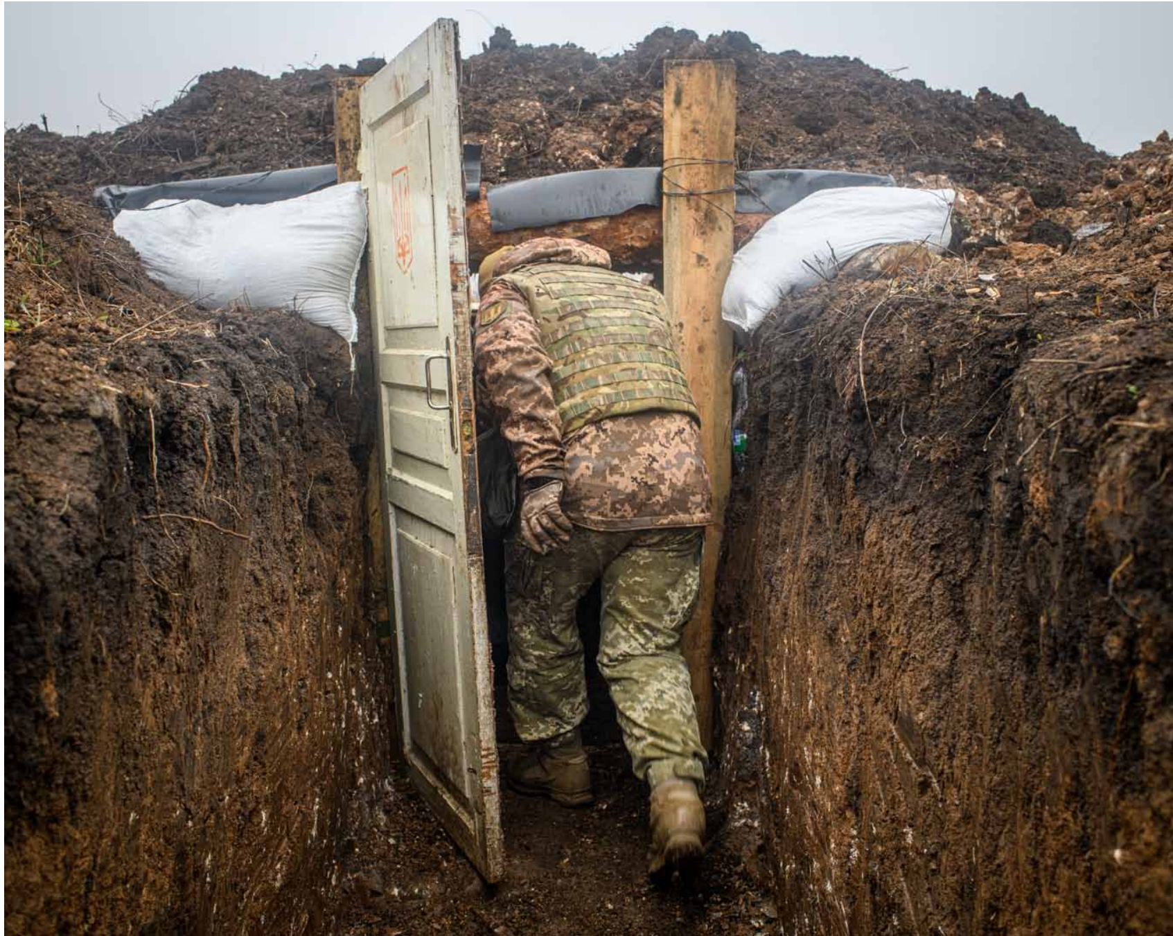
Nouvelles tranchées des forces militaires ukrainiennes construites après le désengagement d'un kilomètre sur la zone de front de Zolote 4.
