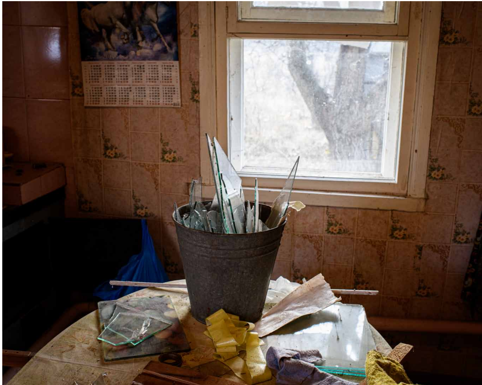
Dans une maison abandonnée du village de Katerynivka du côté contrôlé par les forces ukrainiennes. Le village est situé à 800 mètres de la 1ère ligne de front. La maison a subi des dommages dû à des tirs. Les habitants sont partis en Russie.
