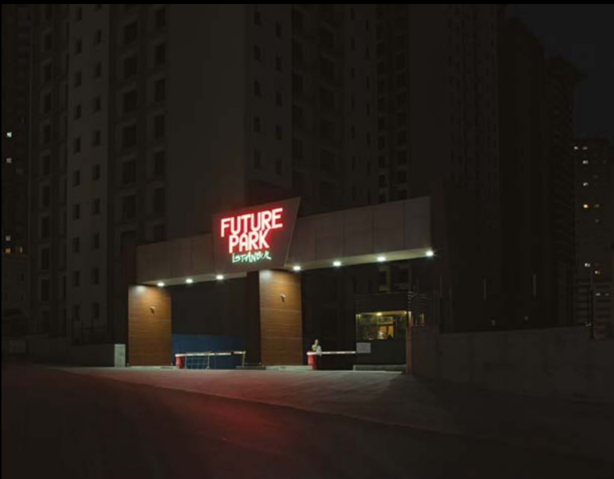
Istanbul, Turquie 2-10-2018 Future Park, complexe immobilier en construction, Julien Chatelin, Esenyurt, 2018 © Julien Chatelin
